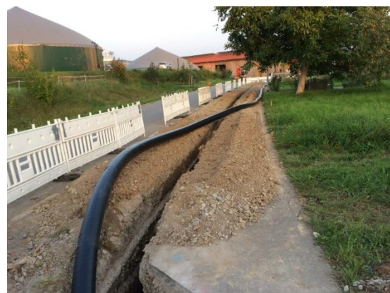
Verlegung der Nahwärmeleitung
